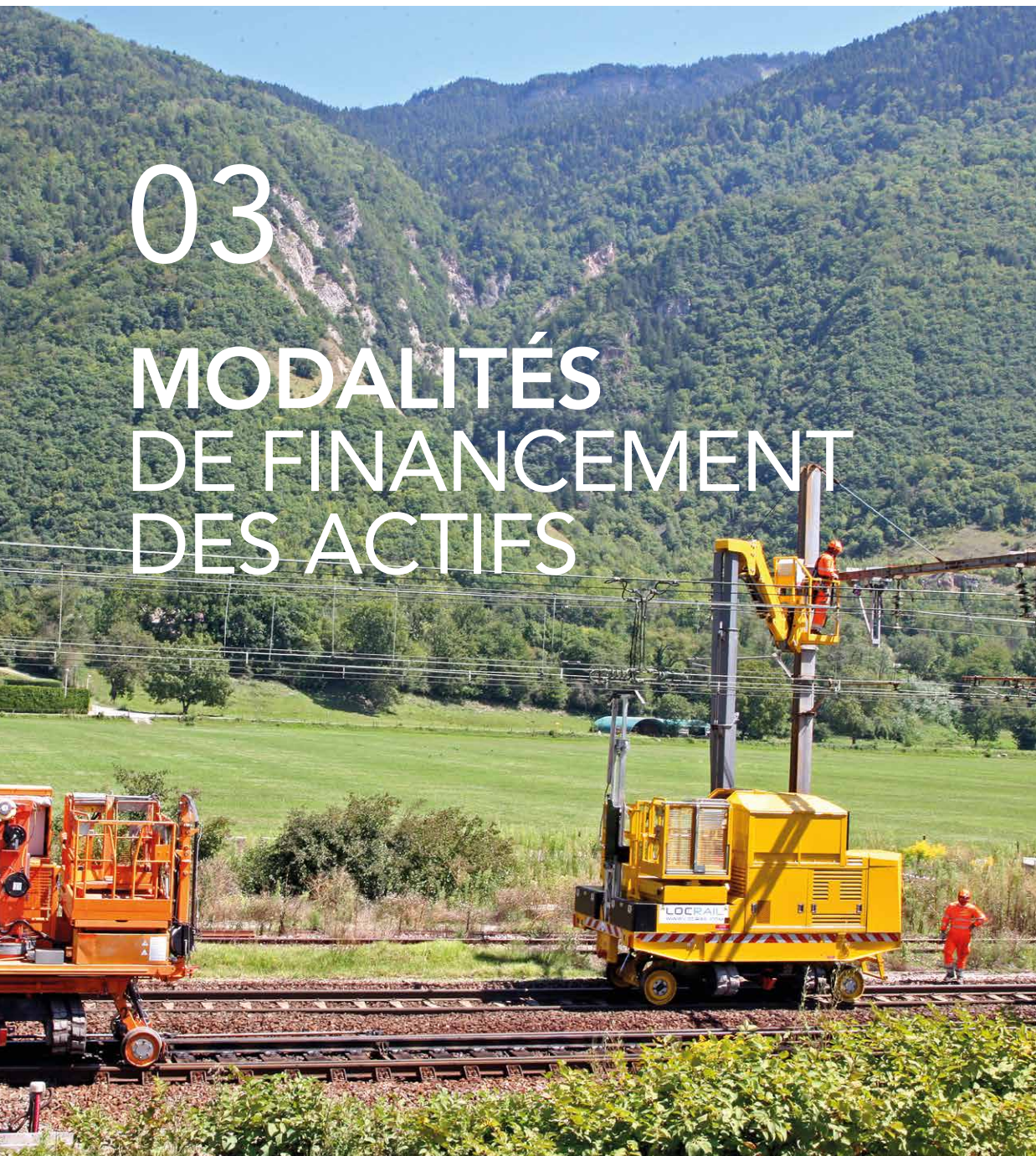
Chantier de construction Liaison ferroviaire fret et voyageurs Lyon-Turin
