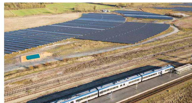
Centrale solaire de la gare de Surdon : mise à disposition par la SNCF d'une ancienne friche industrielle transformée en ferme solaire alimentant chaque année 3 150 foyers.
