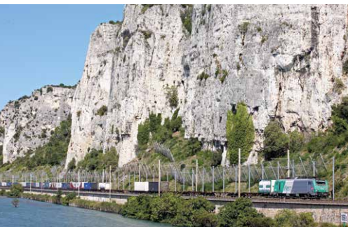
Passage Train FRET dans le défilé de Donzère sur la rive gauche du Rhône.
