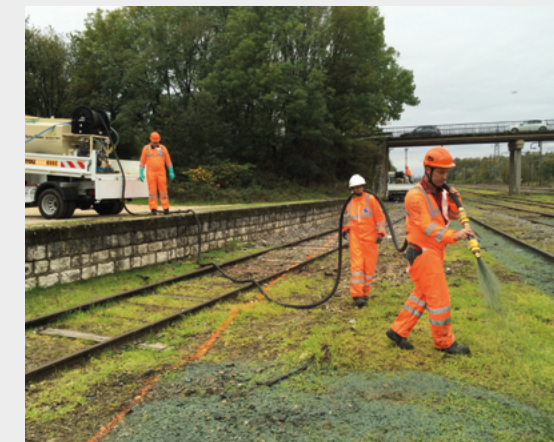
Ensemencement des voies de service par hydromulching, Brevans, octobre 2019 © Anne Petit
