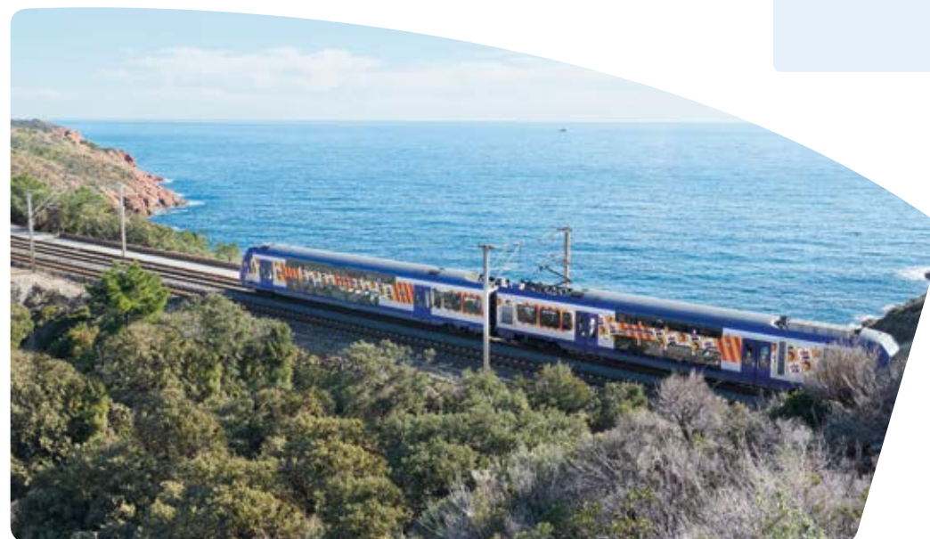
L'ETCS de niveau 2 va permettre de densifier la circulation sur la ligne Marseille-Vintimille.
