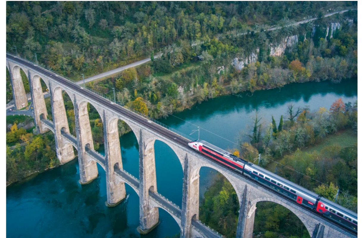
Vue par drone du viaduc de Cize-Bolozon dans l'Ain.
